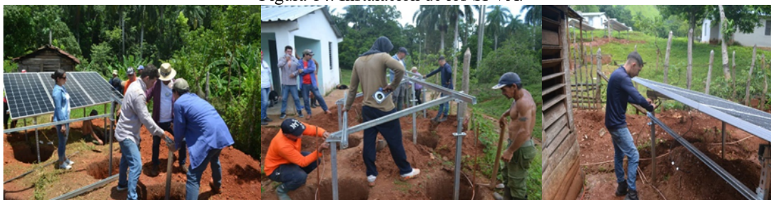
Figura 14. Instalación de los SFVA.
