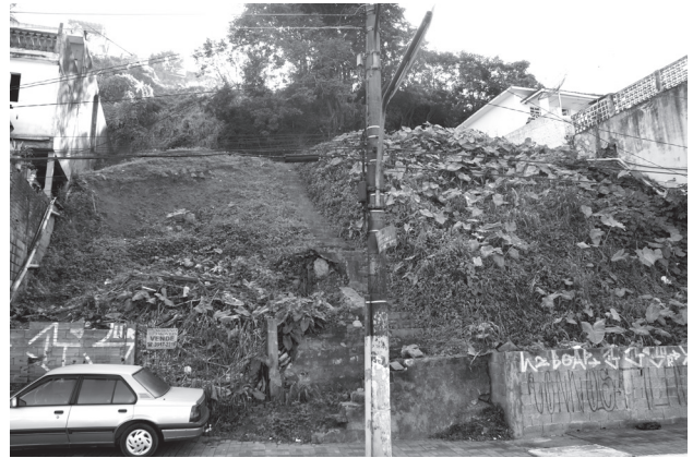
Figura 7. Área de ocupação irregular com risco de deslizamento.
