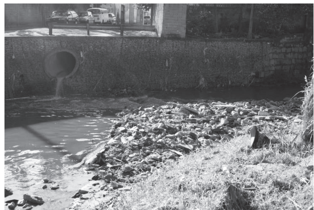
Figura 4. Esgoto jogado no Ribeirão Perus sem tratamento.
