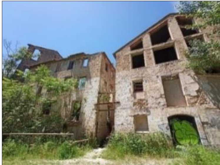
Imatge 13. Malla de protecció per a evitar el desprendiment de vessant darrere de la fàbrica d'Els Solers
