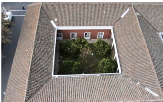
Figura 5: Vista aérea, vivienda típica colonial.
