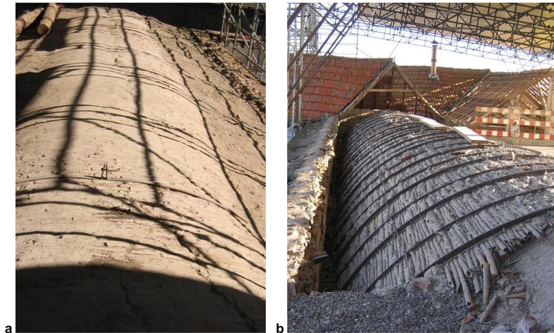
**Figura 8.** *a)* Abóbada composta por elementos cerâmicos e construída no período jesuíta; *b)* Falsa abóbada composta por canas e perfis metálicos construída após 1759. Fotografias ©CME, 2006.
