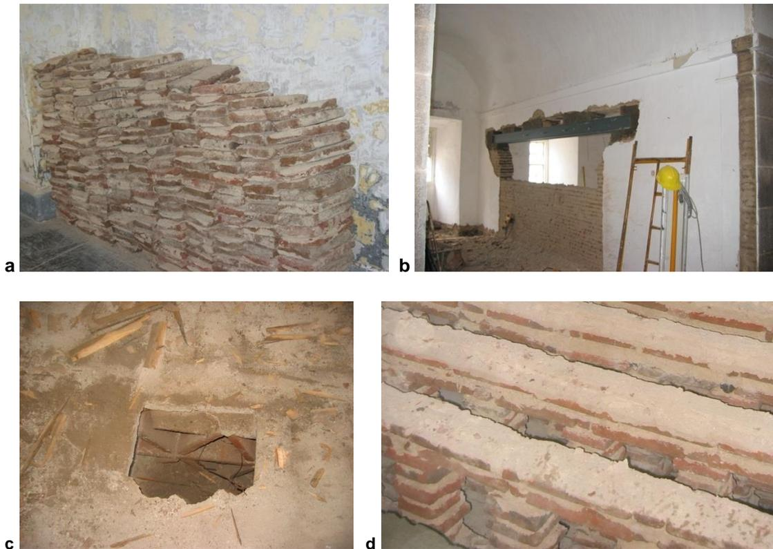
**Figura 10.** Elementos cerâmicos aplicados na construção: *a)* ladrilhos avulsos; *b)* parede com estrutura em ladrilho; *c)* e *d)* ladrilhos aplicados sob o pavimento. ©CME, 2005, 2006.
