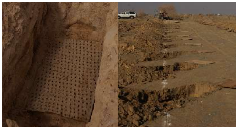
شکل ۲- نحوه کارگذاری صفحه‌های پلانت‌بک در چاله‌های حفرشده
