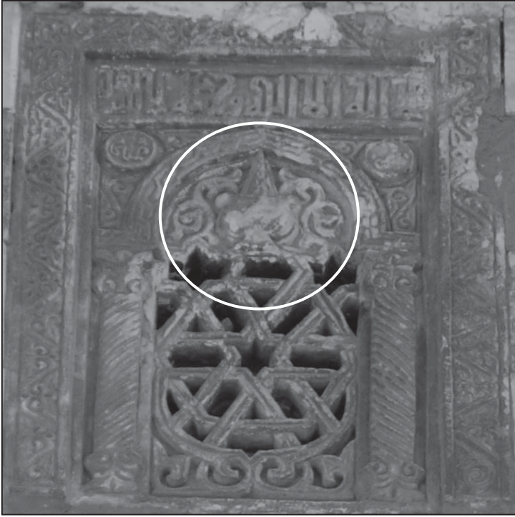
Fig. 2 Panneau de façade de la mosquée al-Aqmar (Le Caire) représentant une lampe suspendue à un arc.
