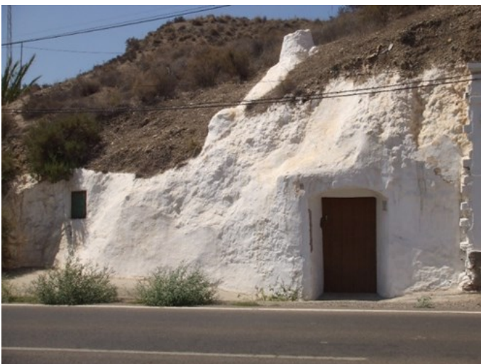
Fig. 2. Detalle de cueva con fachada enlucada sin apenas obra.
