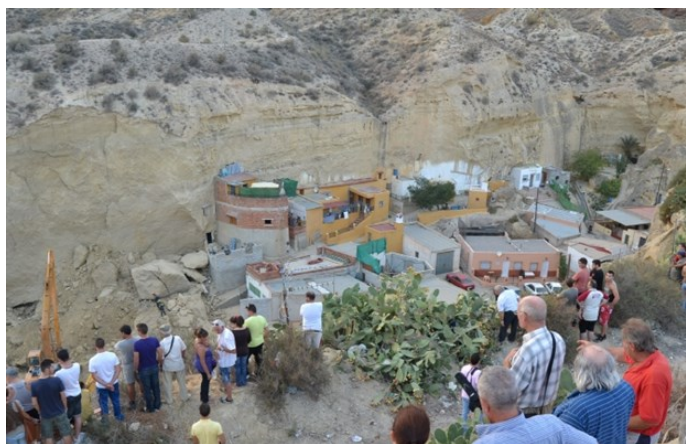
Fig. 6. Accidente de 2001 de derrumbe de tierras en una casa cueva.
