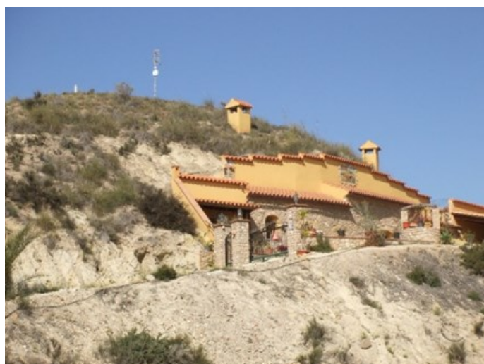
Fig. 7. Detalle de cueva rehabilitada caso de estudio en Cuevas de Almanzora.
