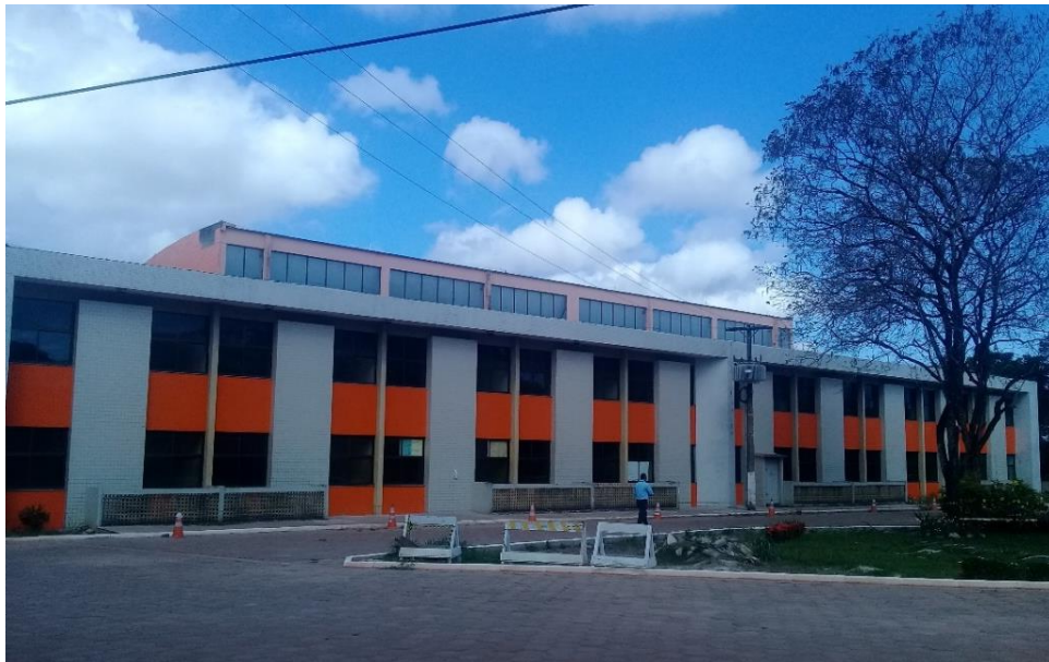
Figura 2 - Prédio “Laranjão” no Campus Tapajós da UFOPA em Santarém-PA
