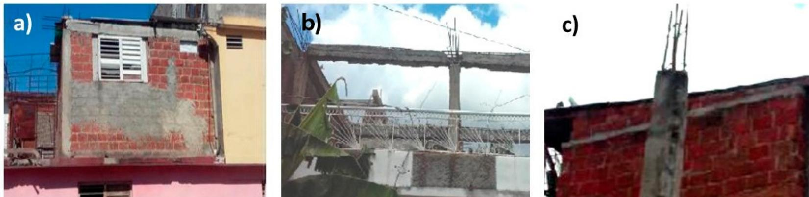
**Figura 1.** Violaciones de los requerimientos de diseño sismorresistente. a) Discontinuidad estructural. b) Mala ejecución del nudo. c) Secciones inadecuadas. Excesivo espaciamiento de cercos.
