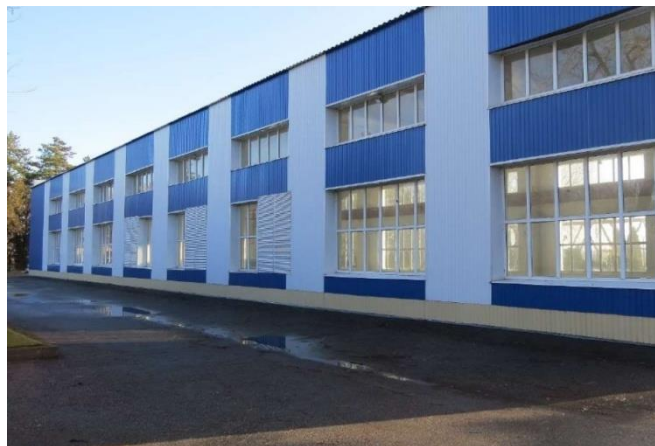
Рисунок 1 – Общий внешний вид насосной станции «Междуречье» (фото В. Н. Ширяева)
