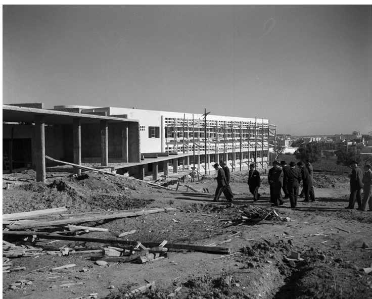
Figura 36 Visita da vereação da Câmara Municipal de Lisboa às obras do Grupo Escolar Célula VII - Alvalade, atual Escola Básica do 1.º Ciclo do Bairro de São Miguel, situada na rua Jorge Ferreira de Vasconcelos, fotografia de Armando Maia Seródio, 1954-10-28. Arquivo Municipal de Lisboa, PT/AMLSB/CMLSB/PCSP/004/SER/000794.
