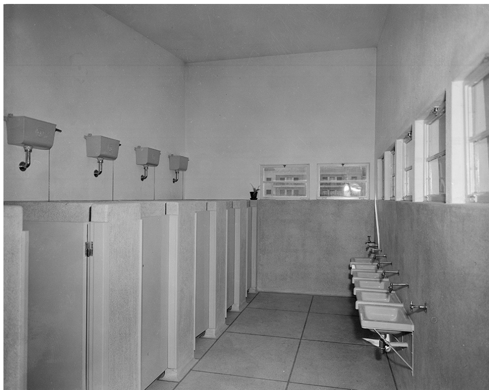
Figura 55 Instalações sanitárias da Escola Primária N.º 24, atual Escola Básica do 1.º Ciclo do Bairro de São Miguel, situada na rua Jorge Ferreira de Vasconcelos, rua António Ferreira e rua Alfredo Cortês, fotografia de Armando Maia Seródio, 1958-10-02. Arquivo Municipal de Lisboa, PT/AMLSB/CMLSBAH/PCSP/004/SER/001143.
