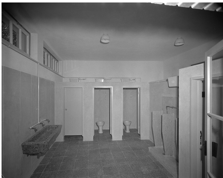
Figura 54 Instalações sanitárias da Escola Primária Nº 63, no Restelo, atual Escola Básica do 1.º Ciclo Nº 63, fotografia de Armando Maia Seródio, 1958-10-02. Arquivo Municipal de Lisboa, PT/AMLSB/CMLSBAH/PCSP/004/SER/001834.
